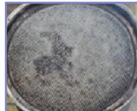
Lokal invändig skada
